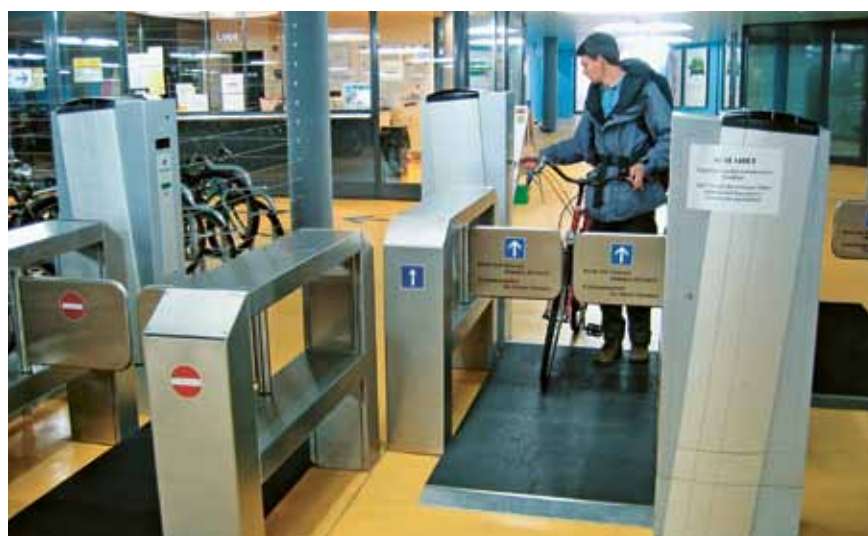
20-4.0 Contrôle des accès automatique
