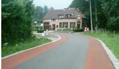
La BCS peut être matérialisée par un **asphalte ou un béton de couleur** différenciée.
