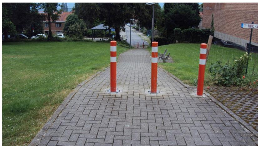
Grâce à cette allée cyclo-pédestre réalisée avec une pente de +/- 10%, Le raccord entre les deux ravel est rendu possible.
