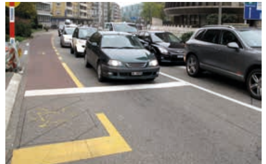
Exemple de boucle de détection sur un sas cycliste, à Bâle.
